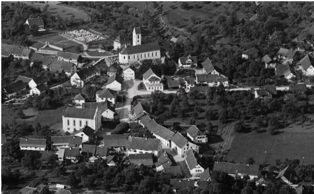
Abbildung 4: Blick auf die Ortsmitte von Lengnau um 1940. ETH Bilddatenbank: MH01-002841
