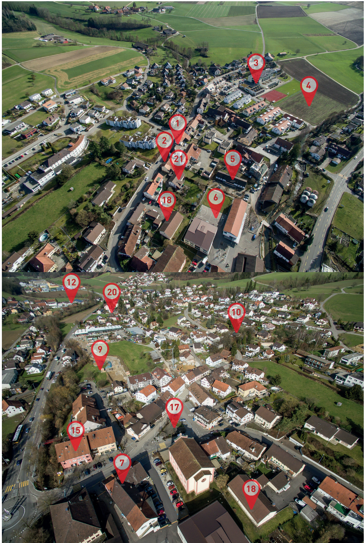
Abb. 4: Luftaufnahmen mit Öffentlichen Bauten
