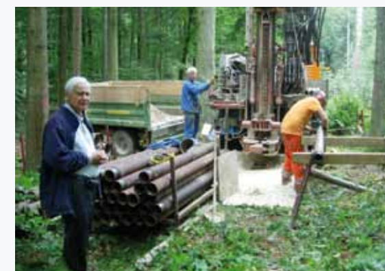
Wasserfreund Bruno Jeggli bei den Bohrungsarbeiten.
